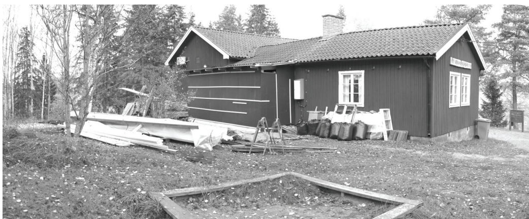
Utbyggnaden har tagit form, men ytterbeklädnad saknas fortfarande
